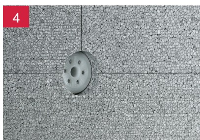
4 łącznik prawidłowo zainstalowany
