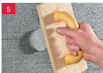
5 założenie zaślepki ejotherm® STR i dociśnięcie pacą w celu uzyskania równej powierzchni
