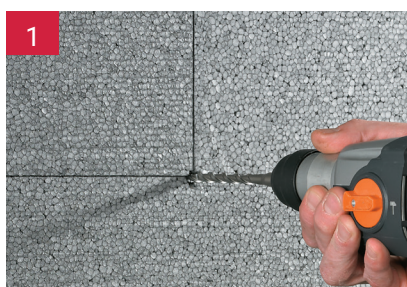
1 wykonanie otworu montażowego
