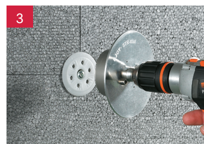
3 wkręcenie śruby i zagłębienie łącznika w termoizolację za pomocą narzędzia ejotherm® STR-tool 2GE
