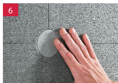
6 gotowe! ...równa powierzchnia termoizolacji
