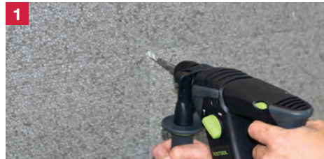
1 szybkie wiercenie otworu, dzięki małej głębokości wierzonego otworu
