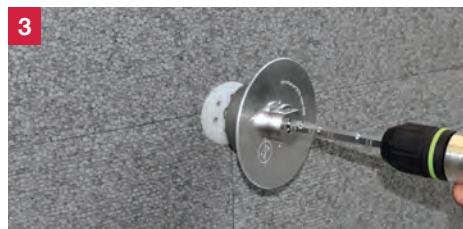
3 wkręcenie za pomocą urządzenia ejothem STR-tool 2GE: automatyczne zagłębienie łącznika (bez frezowania, bez brudu)
