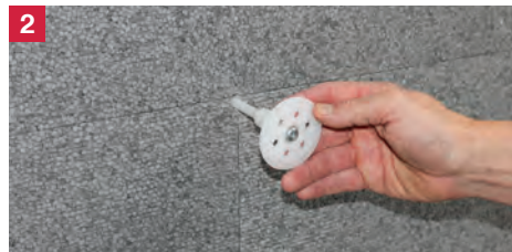
2 włożenie zmontowanego łącznika w przygotowany otwór montażowy
